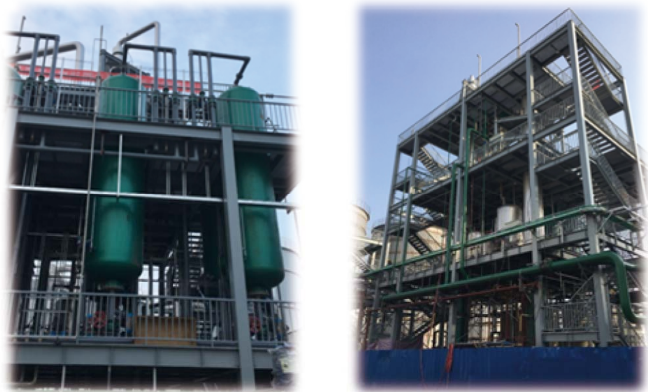
衢州华友2600吨/天硫酸铵除油改造项目现场
